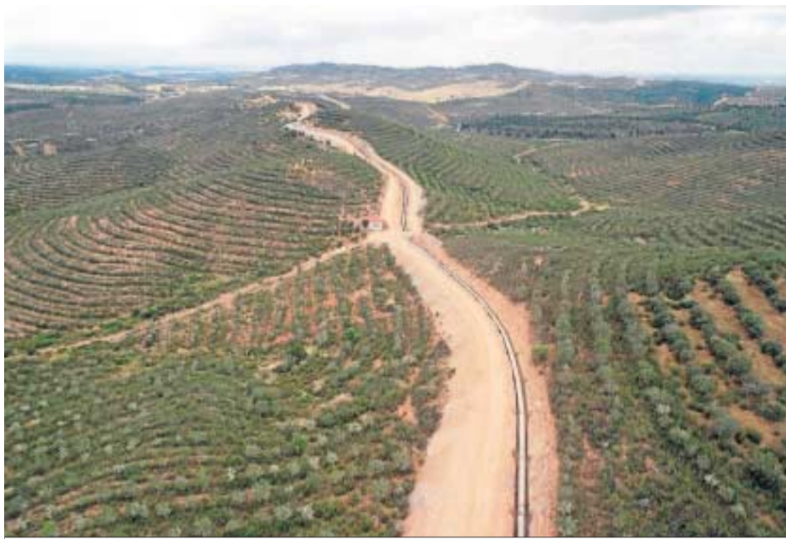
Tubería principal del Sector Sureste, que atraviesa una zona de naranjos.
