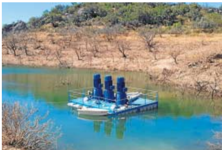
Pantalán y bombas de impulsión del Sector Norte Paymogo.
